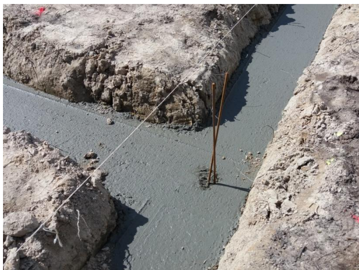
Figure 41 : Fondation coulée avec aciers en attente
