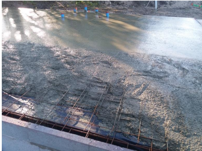
Figure 48 : Réglage de la dalle
