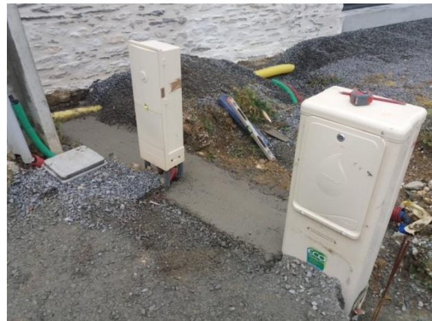
Figure 31 : Fondation coulé au niveau des coffrets
