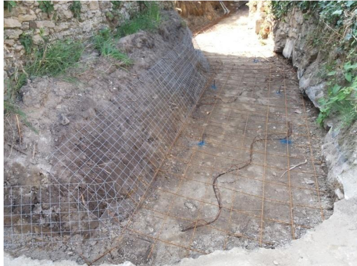
Figure 24 : Ferrailage d'une partie du fond du ruisseau
