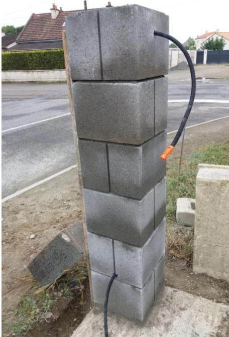
Figure 14 : Poteau de portail
