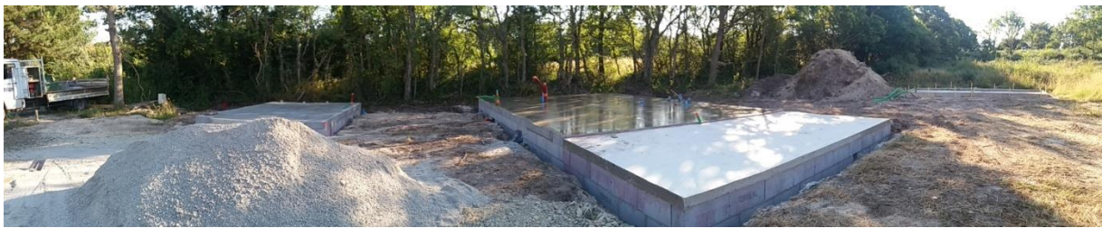
Figure 49 : Chantier à notre départ
