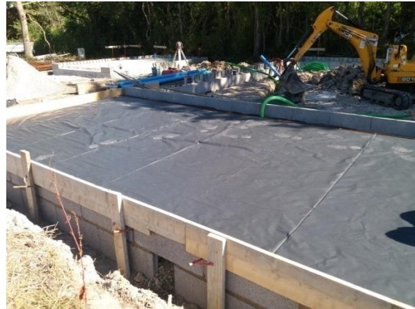
Figure 45 : Coffrage de la terrasse et pose du film polyane
