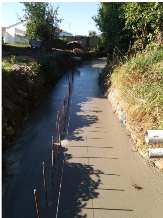
Figure 27 : Bétonnage du fond du ruisseau fini
