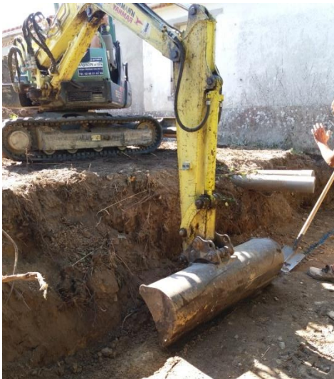
Figure 22 : Nivelage du fond du ruisseau
