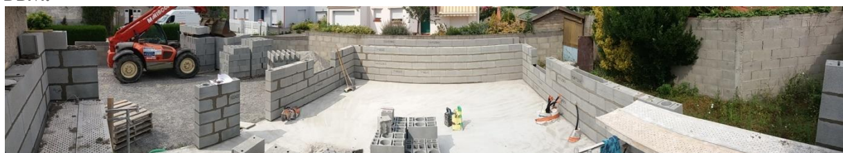
Figure 54 : Chantier à mon départ
