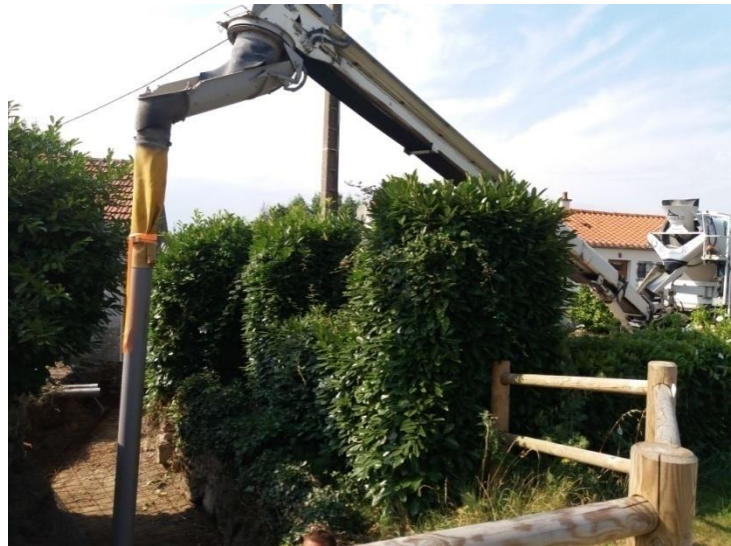
Figure 56 : Bétonnage au tapis
