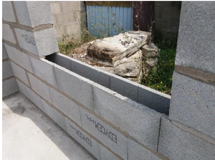
Figure 52 : Allège de fenêtre
