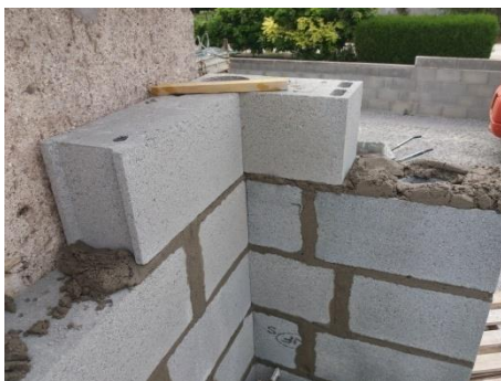
Figure 51 : Mur avec retour
