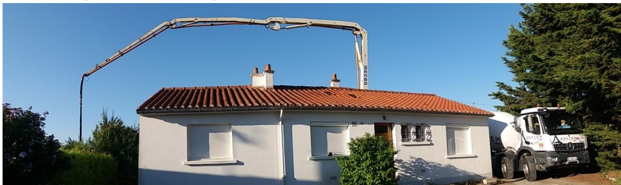
Figure 25 : Bétonnage à la pompe
