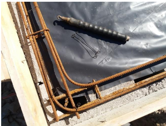
Figure 46 : Chaînage horizontal ligaturé avec équerres
