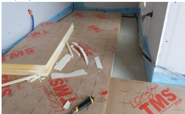
Figure 20 : Pose de l'isolant thermique
