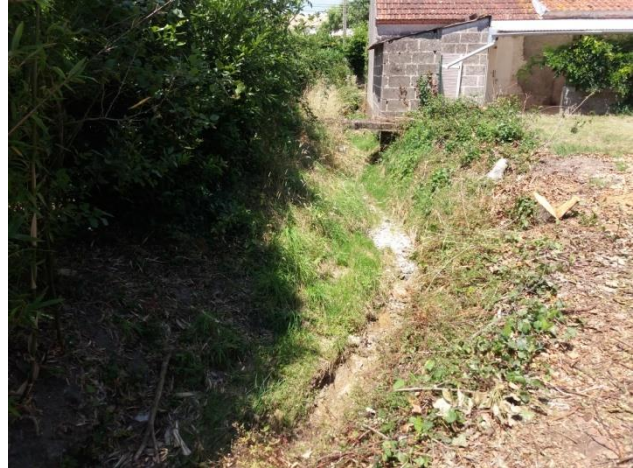
Figure 21 : Une partie du ruisseau à notre arrivée
