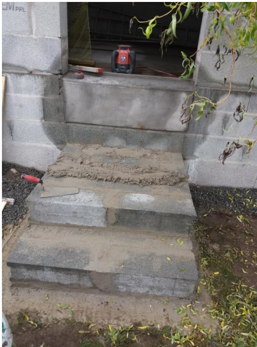
Figure 13 : Construction des marches maçonnées
