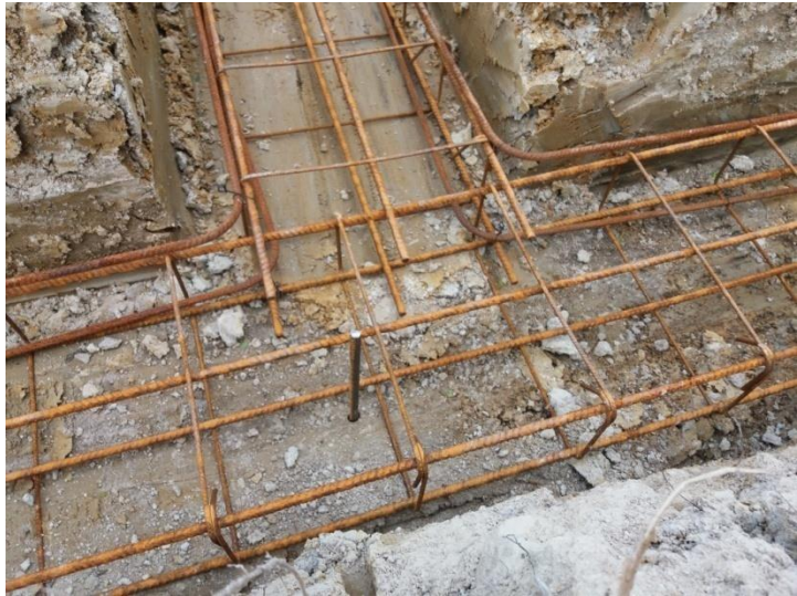
Figure 39 : Ferrailage et piquetage fondations
