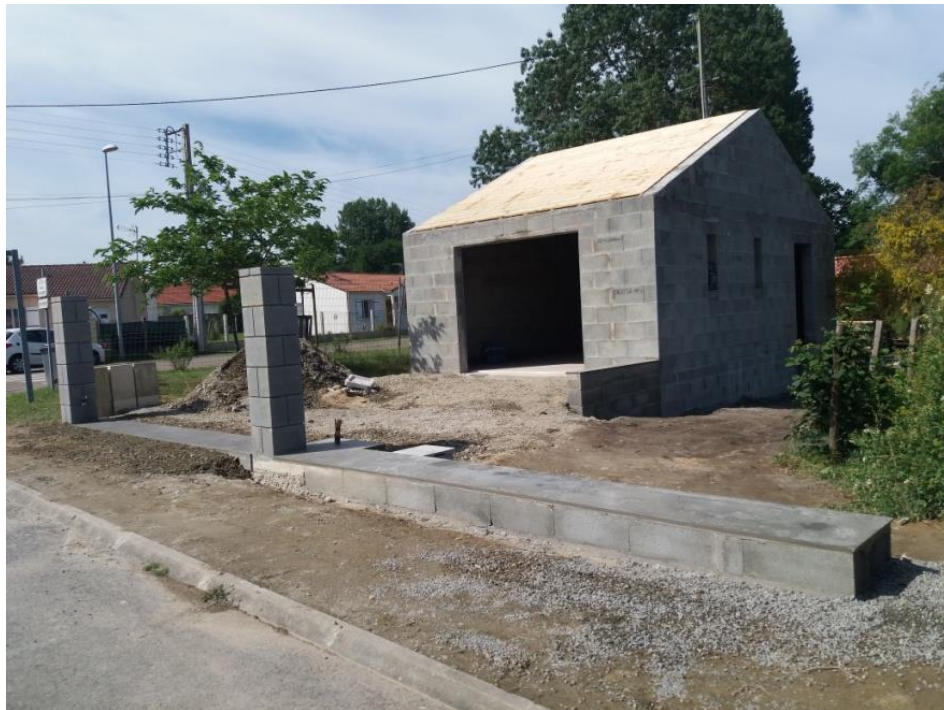
Figure 18 : Chantier à notre départ
