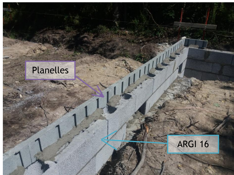
Figure 60 : 2 rangs d'ARGI 16 + 1 rang de planelle
