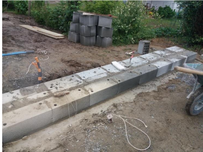
Figure 12 : Seuil de portail
