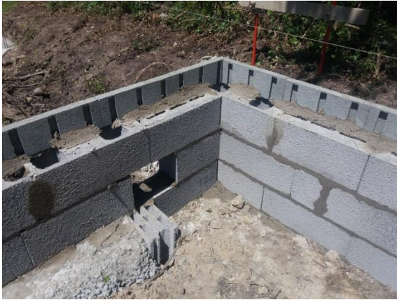
Figure 42 : Pose des ARGI 16 et des planelles
