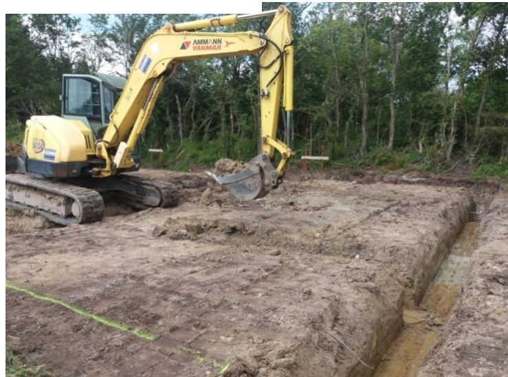
Figure 37 Réalisation des fouilles
