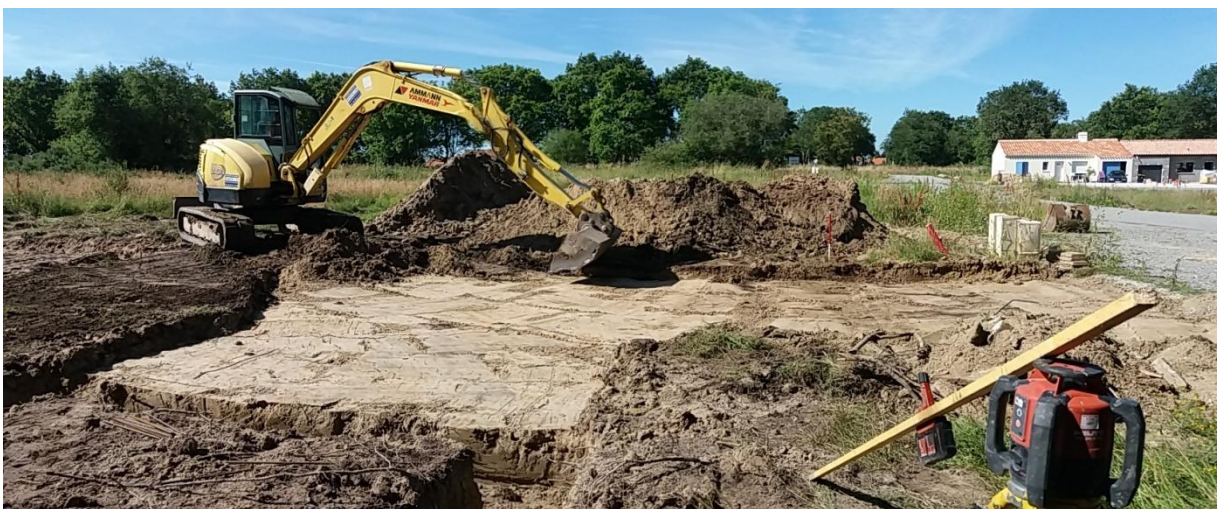
Figure 38 : Réalisation de l'accès
