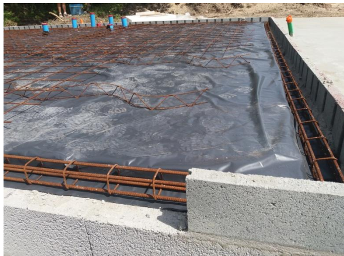
Figure 47 : Ferrailage de la dalle
