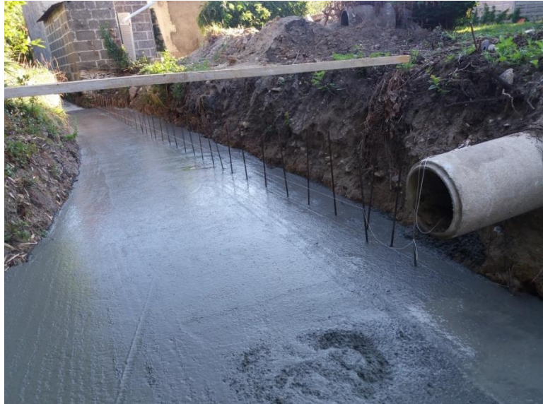
Figure 26 : Bétonnage du fond du ruisseau et pose des aciers en attente
