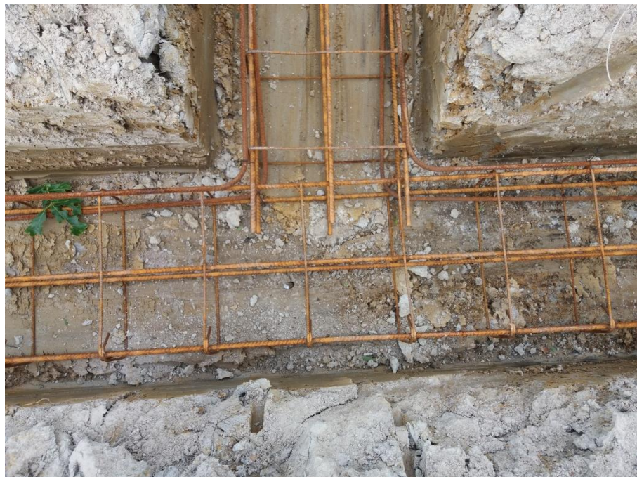
Figure 58 : Cage d'armature 6 HA 10 + Etrépingles HA 10
