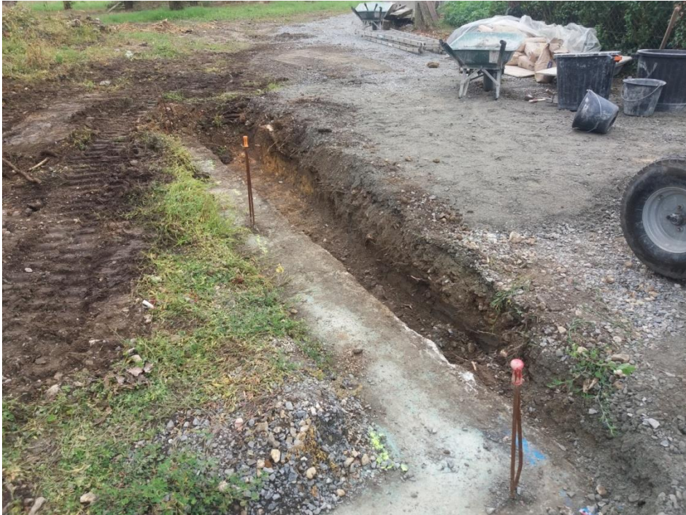
Figure 33 : Fouille de la nouvelle fondation
