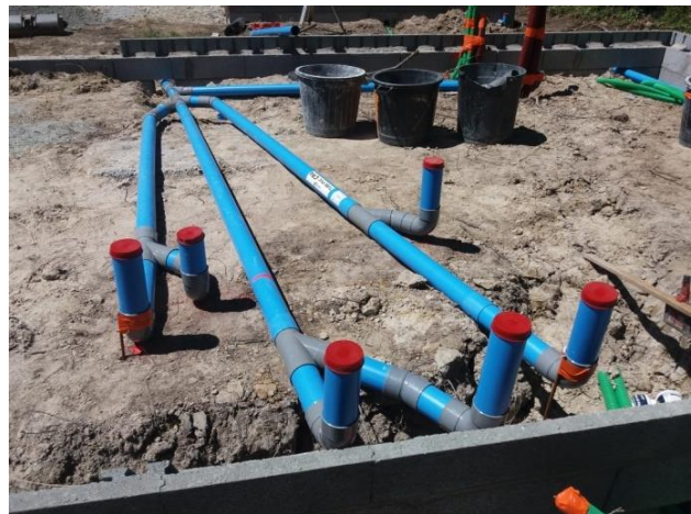
Figure 43 : Mise en œuvre des tuyaux PVC
