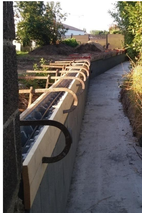
Figure 29 : Coffrage dessus de mur
