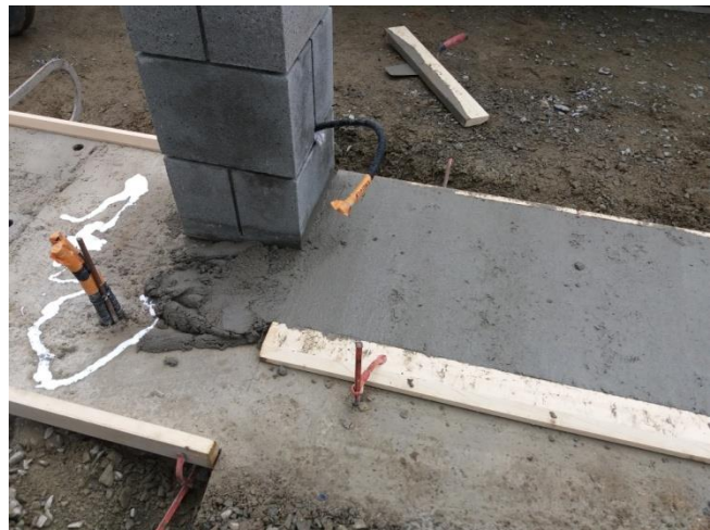
Figure 15 : Seuil de portail (passage)
